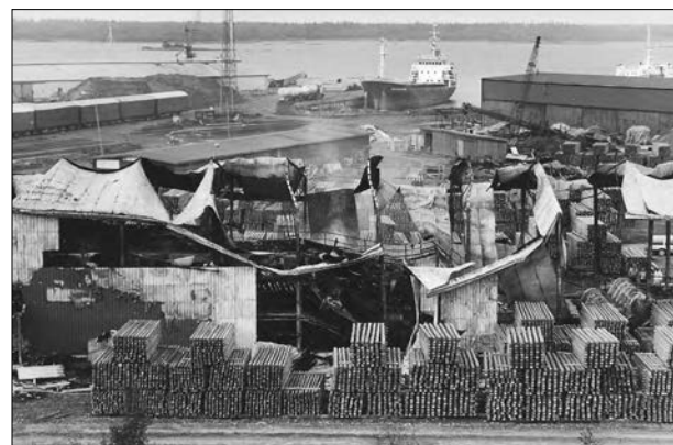
The length sorting plant was destroyed in a fire in 1987. Сортировочное здание сгорело при пожаре в 1987 году.
