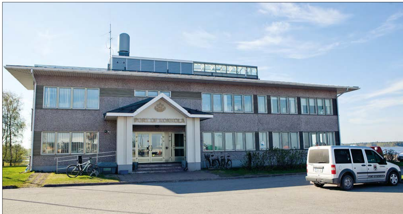
Uusi satamakonttori otettiin käyttöön vuoden 2000 lopussa. Det nya hamnkontoret togs i bruk i slutet av år 2000.
