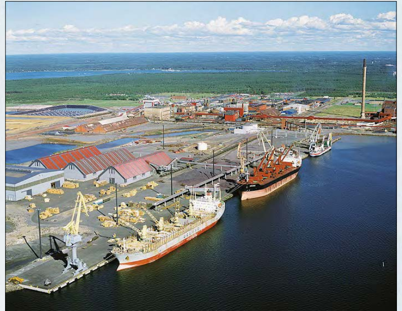
Syväsatama kehitysvaiheessa. Djuphamnen under utveckling.
